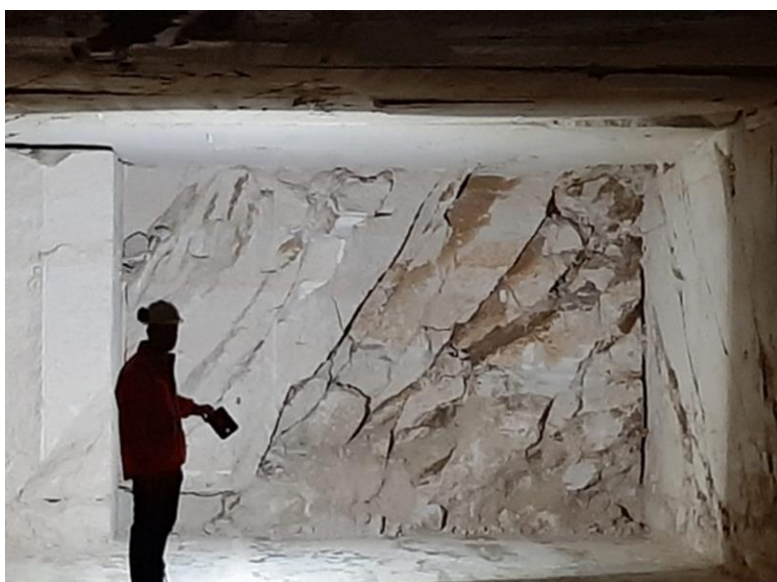
Figure 2 : Exemples de désordres structuraux dans la masse géologique
